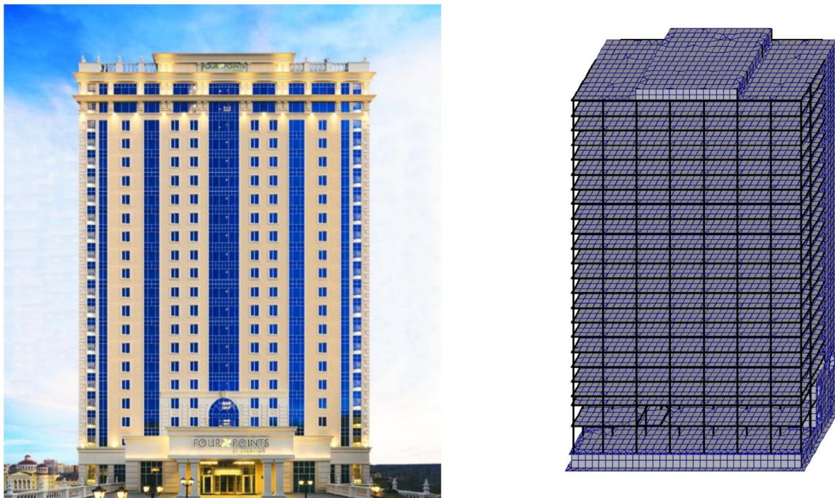
Рис. 1. Здание гостиницы и расчетная схема конструктивной системы [2]
