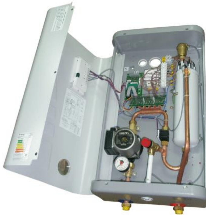
Рис. 1. Все рабочие элементы этого настенного котла находятся внутри корпуса с современным дизайном
