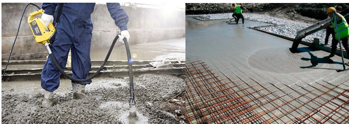
Рис. 1. Бетон с классическим составом без добавления различного вида пластификаторов, требует дополнительных манипуляций, в данном случае уплотнения, при помощи глубинного вибратора (слева). Самоуплотняющийся бетон (справа) лишён подобного недостатка, его можно укладывать большим слоем и без применения вибраторов.
