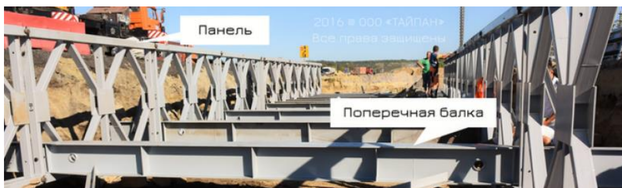
Рис. 3. Объединение несущих конструкций в поперечном направлении
