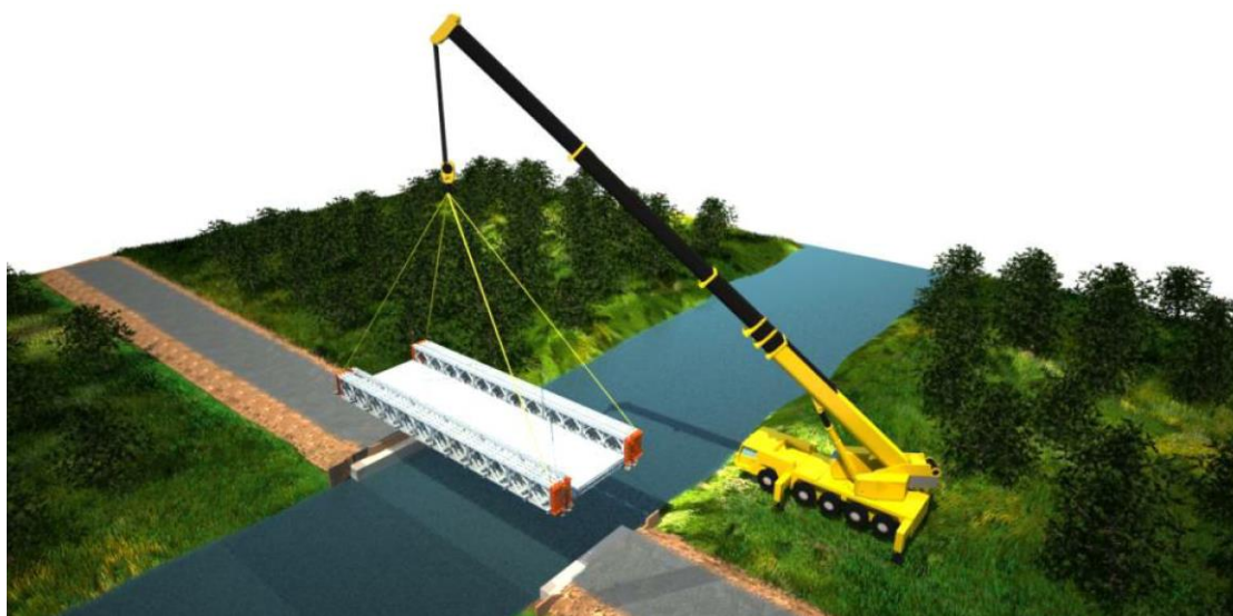
Рис. 5. Монтаж пролетного строения при помощи автодорожного крана
