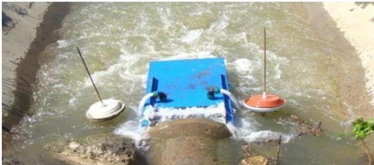
Рис. 2. Регулятор уровневому режиму воды в оросительном канале
