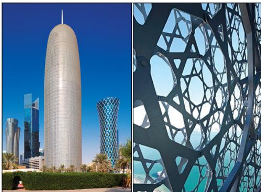
Рис. 4. Burj Doha (Доха, Катар). Постройка высотой 231 м имеет сетчатый металлический фасад, выполняющий роль экрана от жаркого солнца (фото с сайта https://www.abok.ru/for_spec/articles.php?nid=5890/ , дата обращения 11.09.2023)
