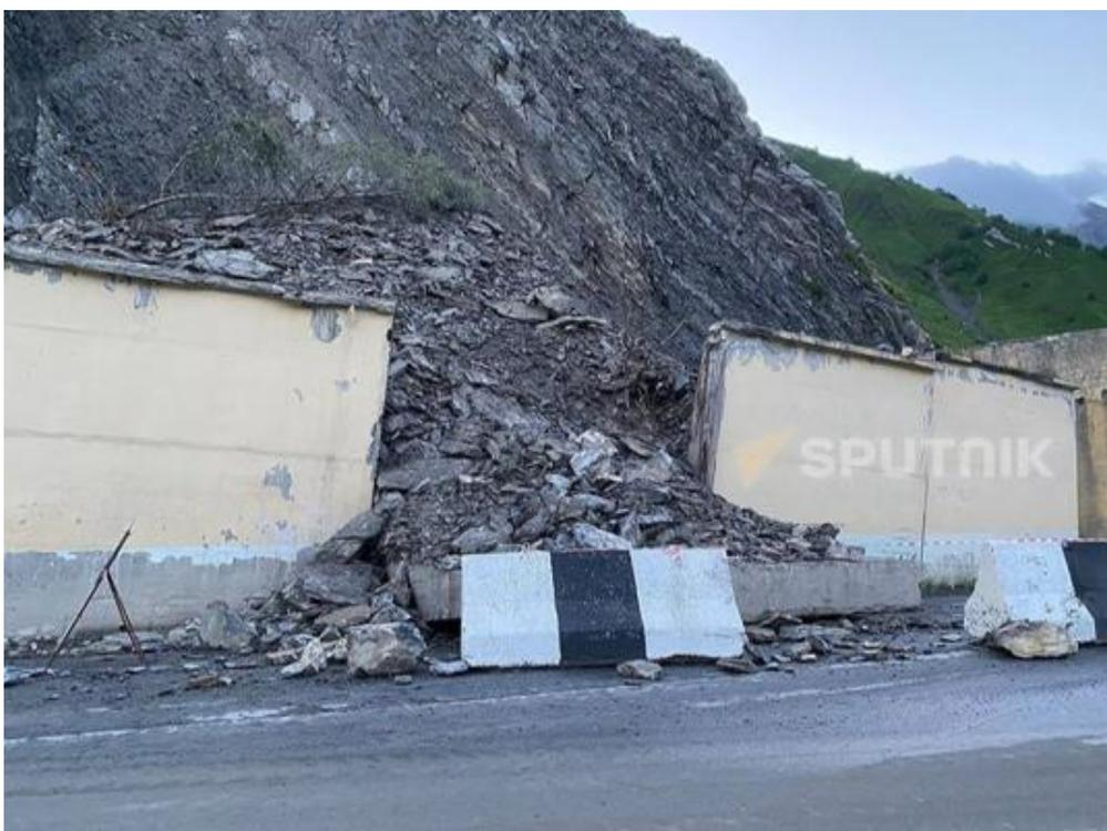
**Рис. 5. Подпорная стена на Транскаме под воздействием обвально-осыпной массы хлынула на проезжую часть**
