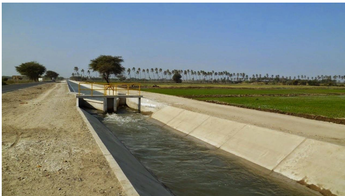
Рис. 2. Бетонная облицовка оросительного канала
