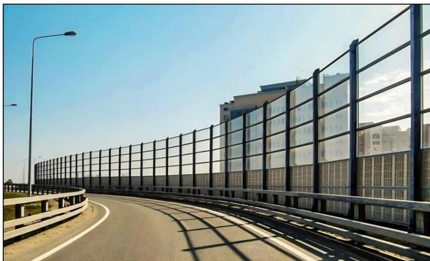
**Рис. 3. Пример акустического экрана на магистрали**
