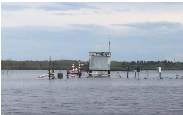
Рис. 4. Затопленная кустовая площадка в паводковый период
