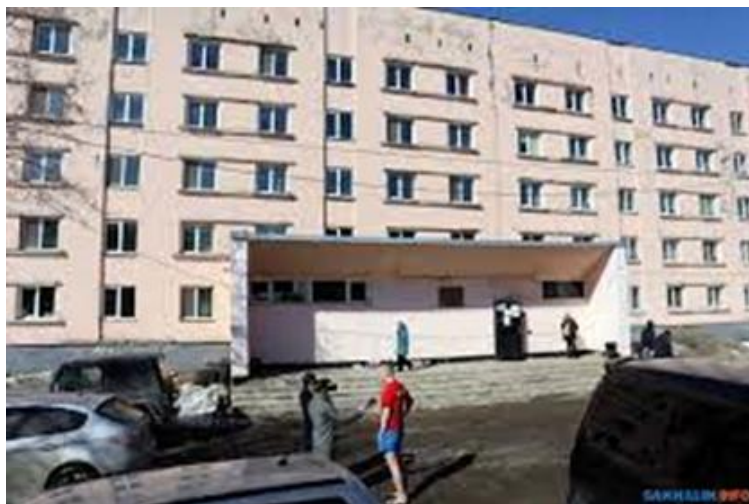
Рис. 5. Фотофиксация состояния жилых студенческих корпусов в настоящее время
