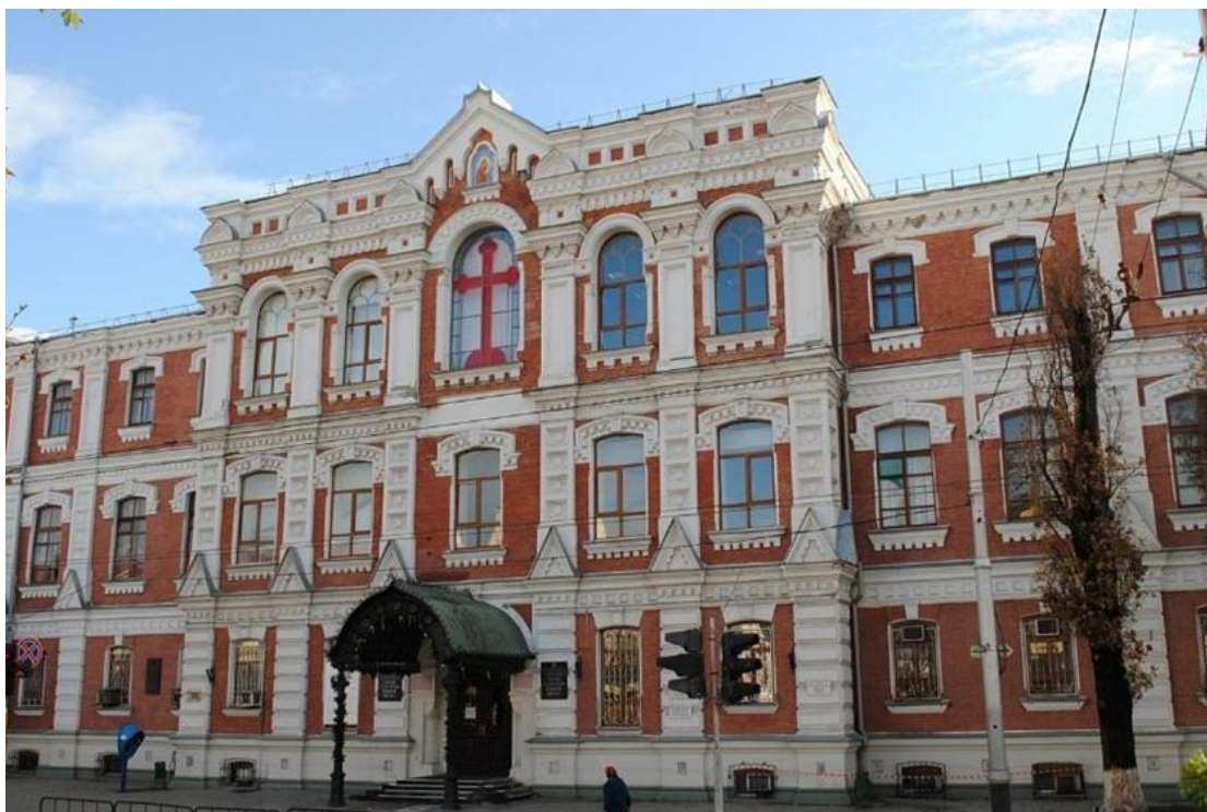
Рис. 6. Фасад здания, восстановленный витраж.
